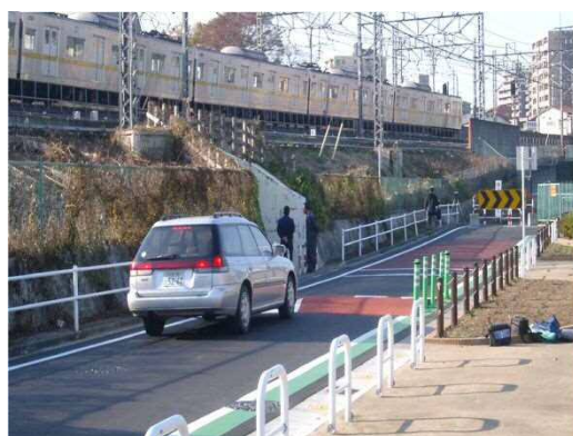
サインカーブハンプ (埼玉県朝霞市)
