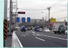
右・左折レーンの設置：横浜市
